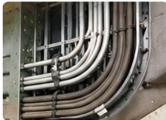
Roteamento e fixação de cabos
